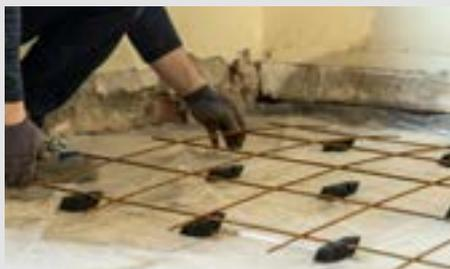
Posizionare la rete elettrosaldata di armatura del solaio utilizzando dove possibile la scanalatura centrale del connettore CSC 45 PowerFast: così facendo si realizza la corretta distanza della rete dall'elemento ligneo sottostante e la legatura di sospensione non è necessaria.
