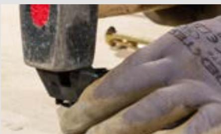
Bloccare i connettori CSC 45 PowerFast nella giusta posizione usando un martello. I dentini perforanti stabilizzano il connettore sull'elemento ligneo sottostante. Nel caso di essenze particolarmente dure o condizioni del supporto non adeguate, è consigliabile usare una vite  $\varnothing 5$  sfruttando l'apposito foro presente sulla parte centrale del connettore.
