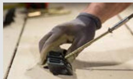
Avvitare le 2 viti Power-Fast FPF-ST 8,0x160 YZP utilizzando i fori guida inclinati a 45° fino alla precisa battuta indicata degli alloggiamenti svasati.
