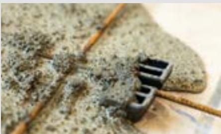
Eseguire il getto di calcestruzzo fino allo spessore di dimensionamento. Trattandosi di un sistema a secco, è possibile realizzare la soletta in calcestruzzo subito dopo aver eseguito le precedenti lavorazioni.
