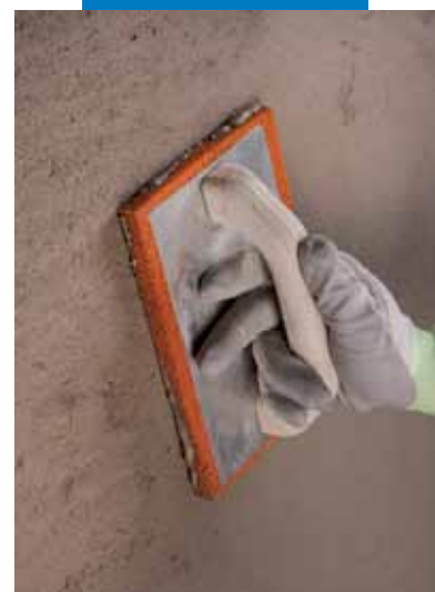
Frattazzatura di Planitop Rasa & Ripara
