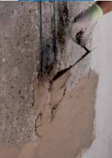
Applicazione a cazzuola di Planitop Rasa & Ripara
