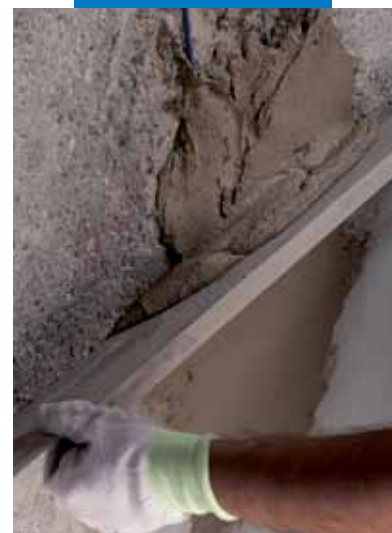
Staggiatura di Planitop Rasa & Ripara
