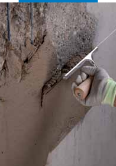
Applicazione a spatola di Planitop Rasa & Ripara
