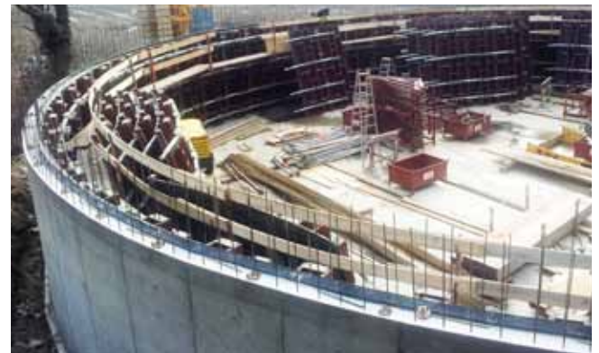
fase di ripresa - H. 6,0 m
