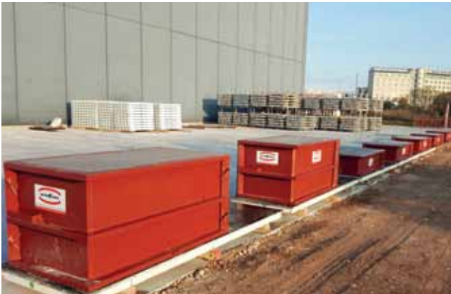
I blocchi di cls. possono essere costruiti direttamente in cantiere o nel magazzino.
