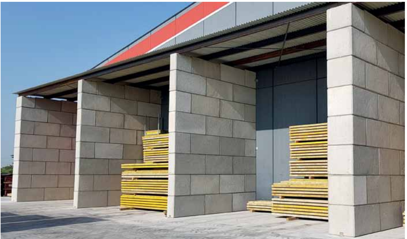
I blocchi di cls. possono essere costruiti direttamente in cantiere o nel magazzino.
